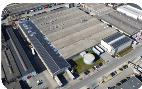
Panneaux solaires site Plastuni Opérations
