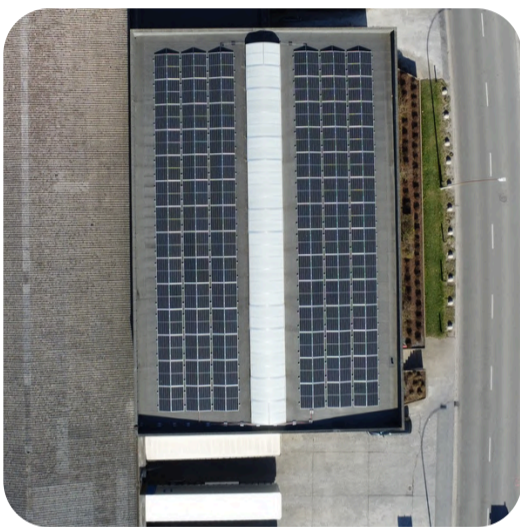
Parc photovoltaïque de Plastuni Opérations
